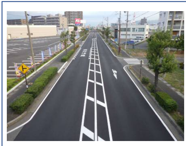
舗装修繕工事 完成
