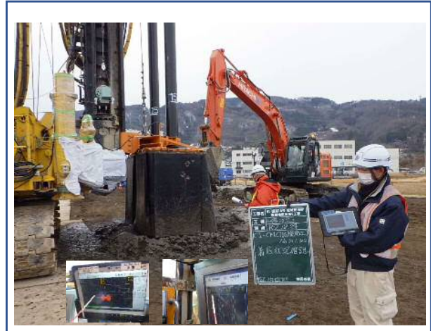
ICT建機による着底状況確認
