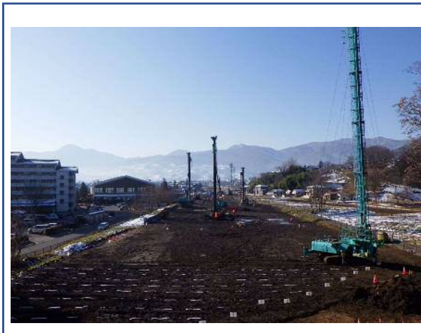
バーチカルドレン工の施工状況
