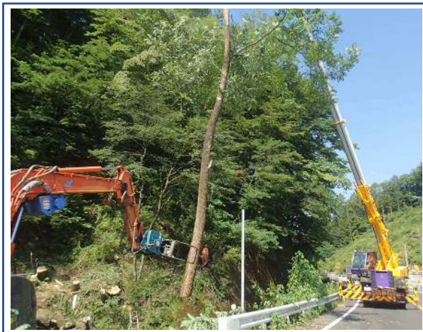
支障木伐採状況
