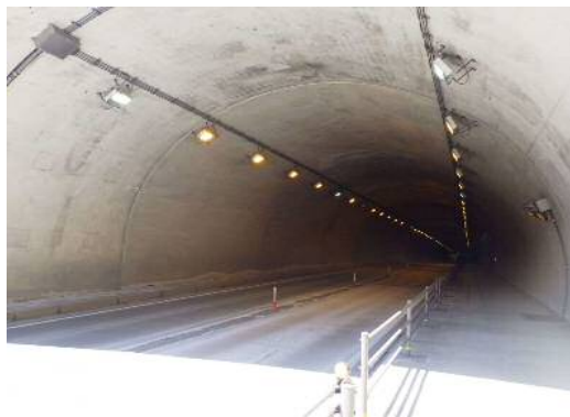
トンネル照明灯更新 完成
