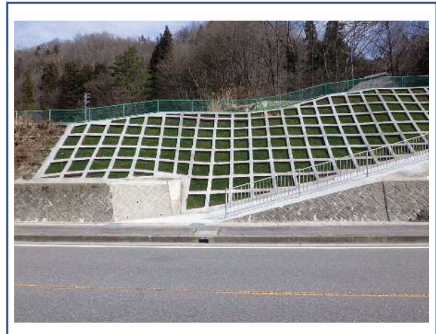
法枠工、代替道路 完成
