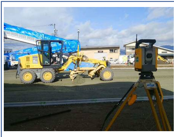
I T C 舗装の施工状況
