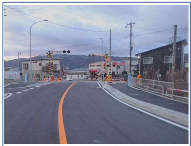
歩道設置完成状況
