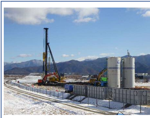
地盤改良（固結工）の施工状況
