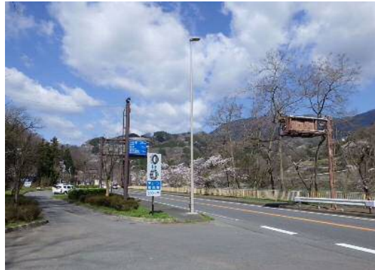
道路照明灯更新 完成
