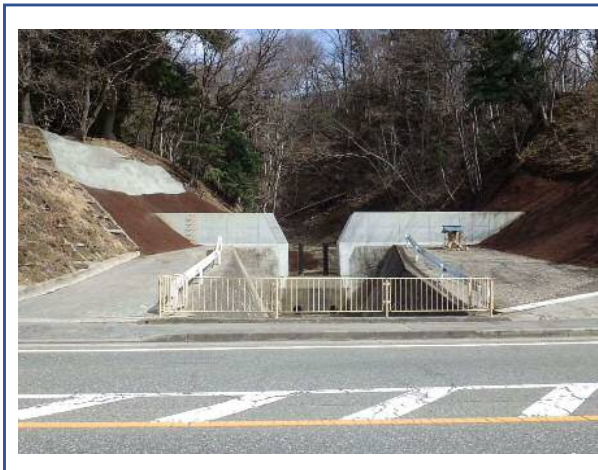
嵩上げコンクリート工 完成
