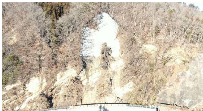
日原日地先応急復旧工事完了
