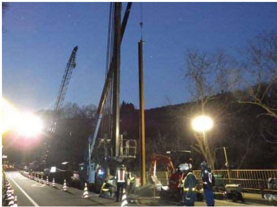
鋼矢板打設作業
