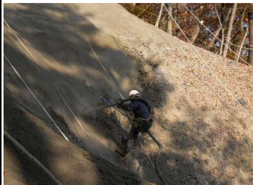
法面吹付作業
