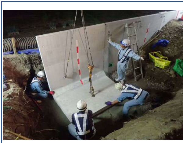
L型擁壁工 施工状況
