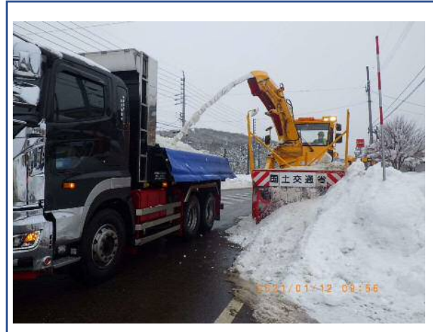
拡幅除雪作業
