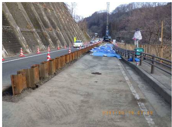
緊急復旧完成
