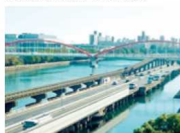
大規模更新施工前の状況
