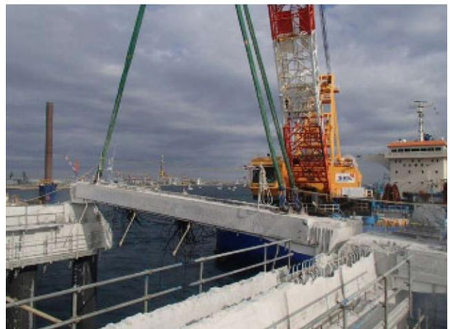
写真-2 被災したPC桁の撤去状況
