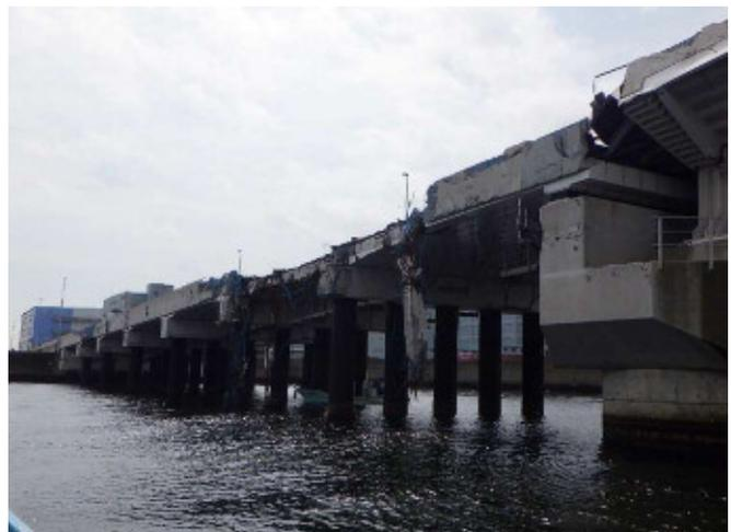
写真-4 PC栈橋部の被災状況
