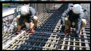
鉄筋組立完了時 (出来形確認状況)
