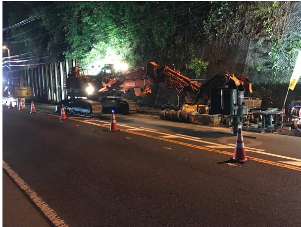
7月15日 夜間 杭打ち機解体作業
