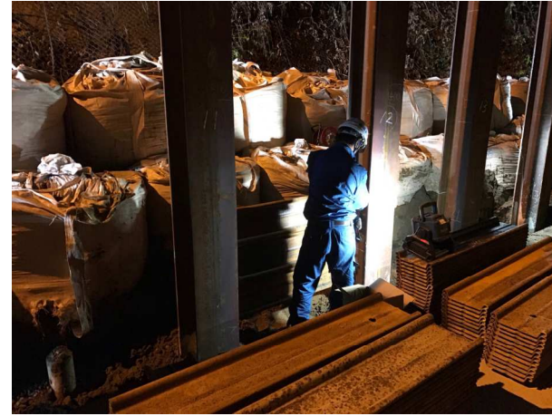
7月15日 夜間 横矢板設置作業
