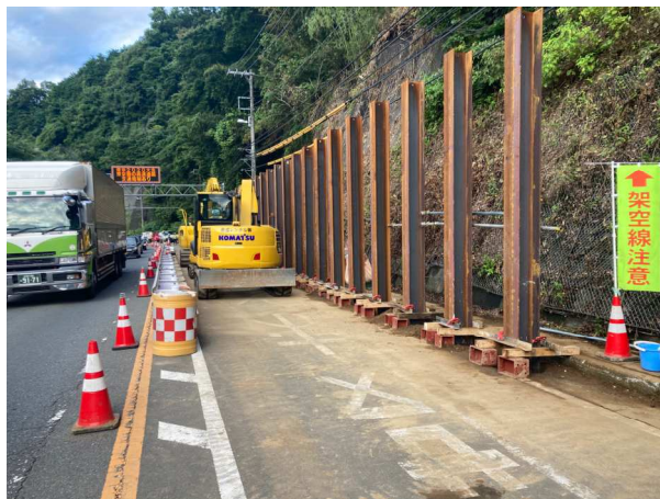
現場状況(東京側)
