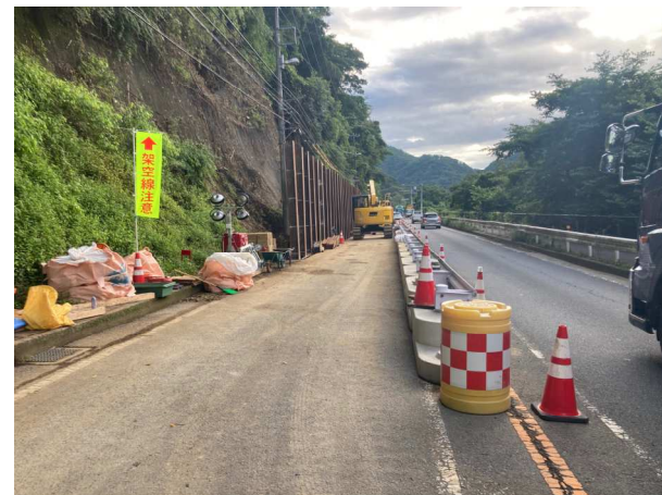
現場状況(御殿場側)
