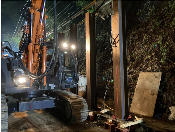
7月14日 夜間杭打ち作業
