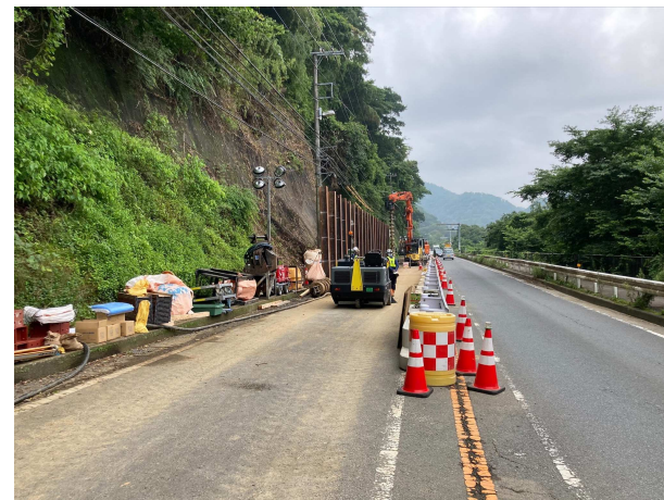
現場状況(御殿場側)
