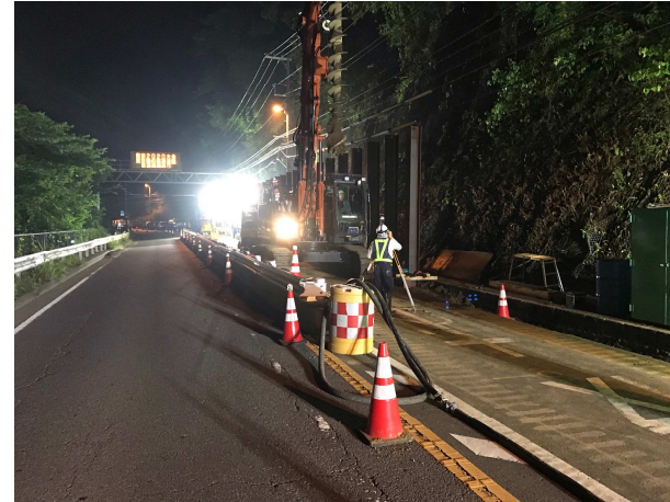
7月14日 夜間杭打ち作業
