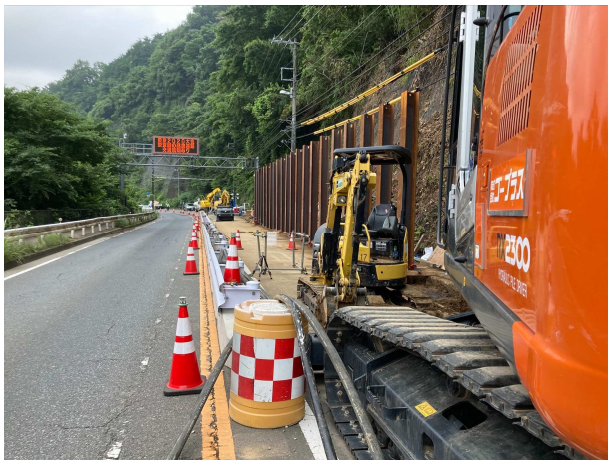
現場状況(東京側)
