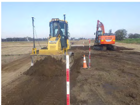
【盛土施工状況】
