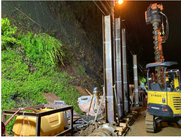
7月13日夜間杭打ち作業
