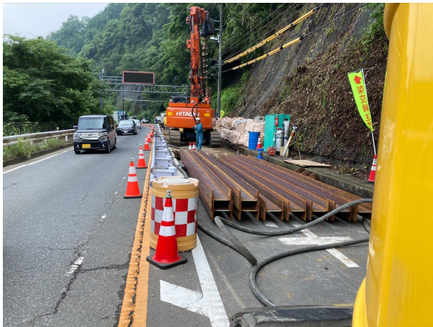
現場状況(東京側)
