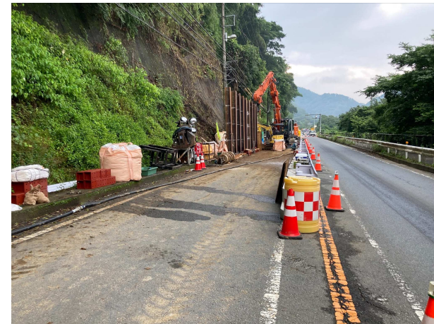
現場状況(御殿場側)
