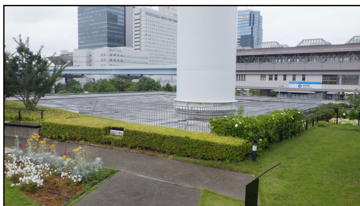
屋上防水層 現況
