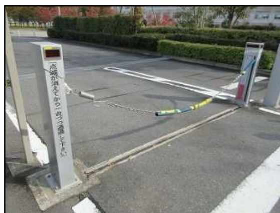
入口ゲート 現況
