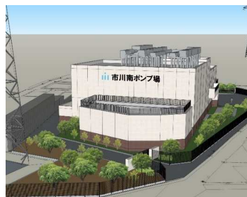
市川南ポンプ場イメージ(建設中)
