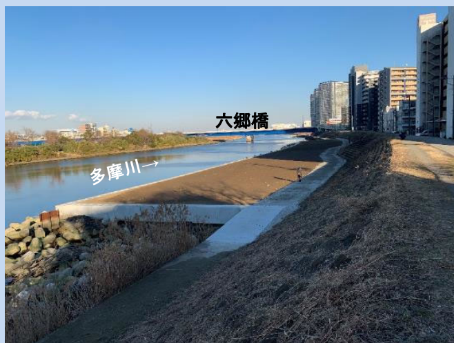
工事着手前(令和3年1月)
