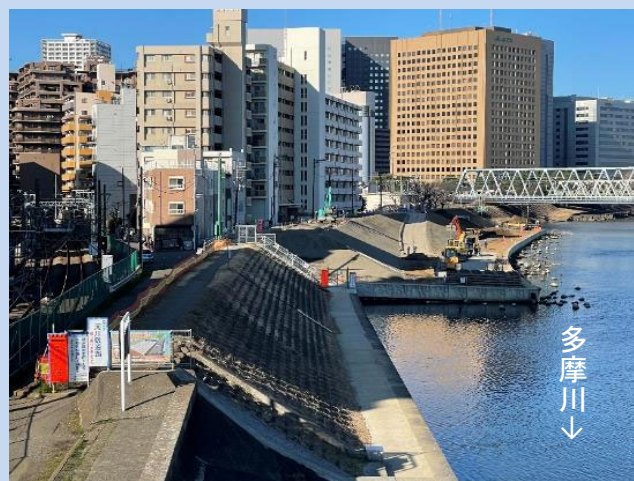
護岸の上に盛土をしています。 (令和4年2月)
