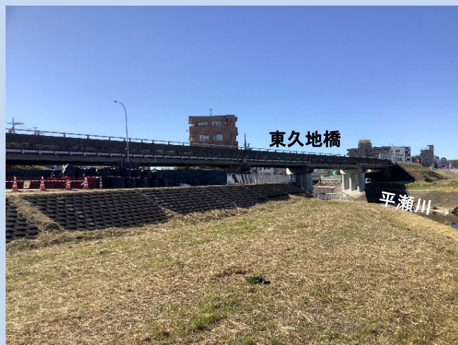
工事着手前(令和3年2月)
