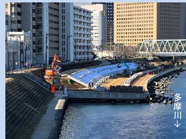
盛土をして大きくした堤防に、 護岸を施工しています。(令和3年12月)
