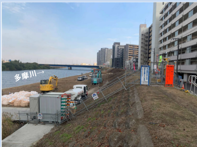
盛土の準備をしています。 (令和3年11月)
