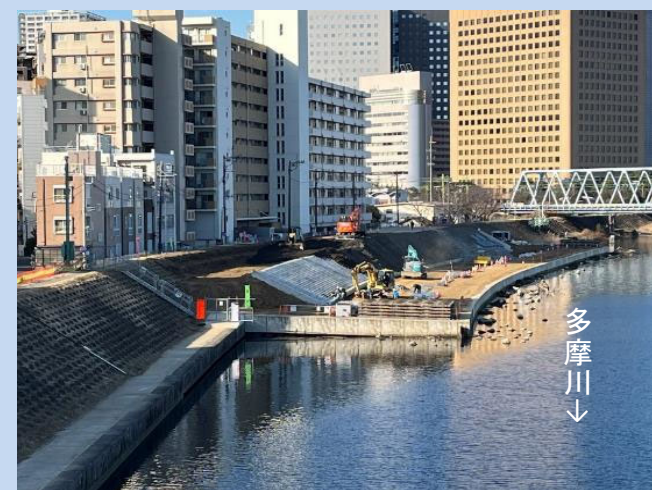
護岸の上に盛土をしています。 (令和4年1月)
