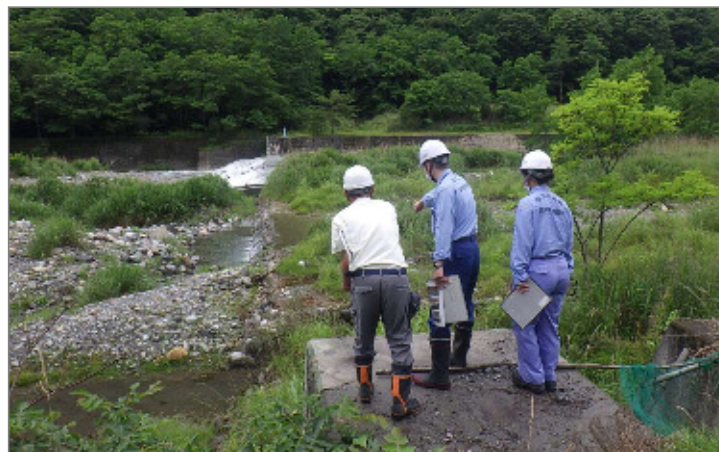
▲釜無川上流域の点検状況
