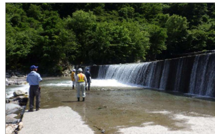
▲大武川流域の点検状況
