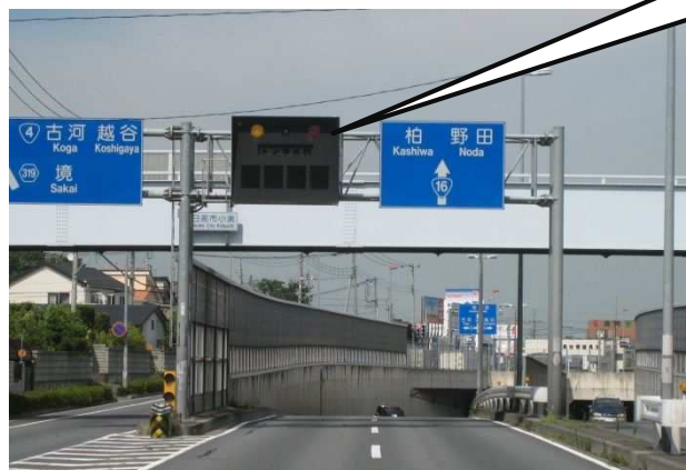
②電光掲示板(地下道手前の情報提供)
