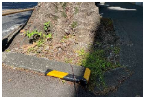
縁石の持上げによる段差(写真は注意喚起のテープ添付)
