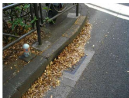
排水施設への落葉の堆積
