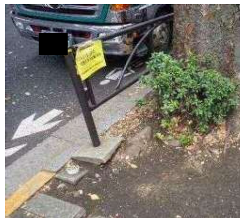
圧迫に対応し接触部分を撤去した例
