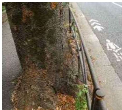
肥大した幹による防護柵の圧迫・被害
