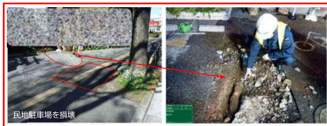
歩道舗装を補修してもその後の根の伸長・肥大により再び亀裂が繰り返し発生
