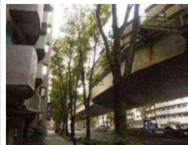
狭い空間に大きく樹木が生長した区間
