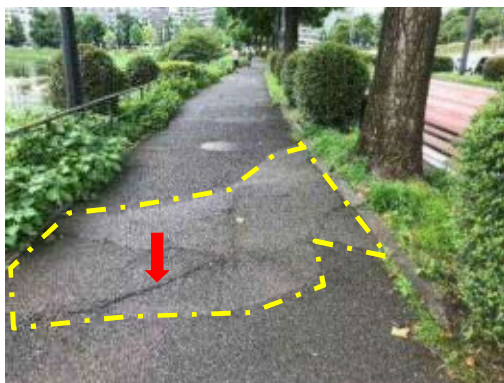
歩道舗装を補修してもその後の根の伸長・肥大により再び亀裂が繰り返し発生
