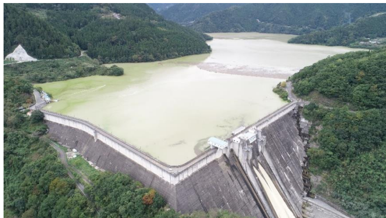
下久保ダムの洪水貯留状況
