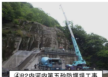
④R2内河内第五砂防堰堤工事
