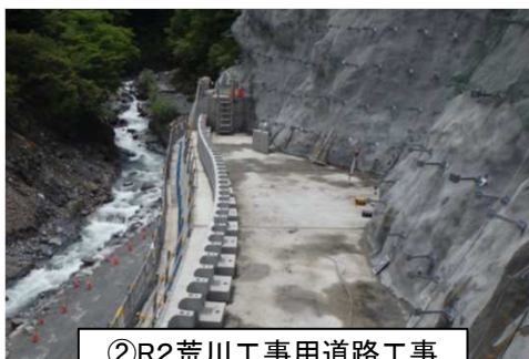
②R2荒川工事用道路工事
