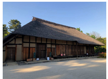
こもれびの里 主屋外観
