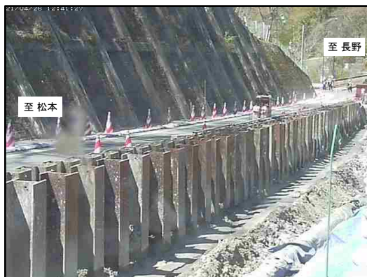
応急復旧(補強H鋼杭)の施工状況
