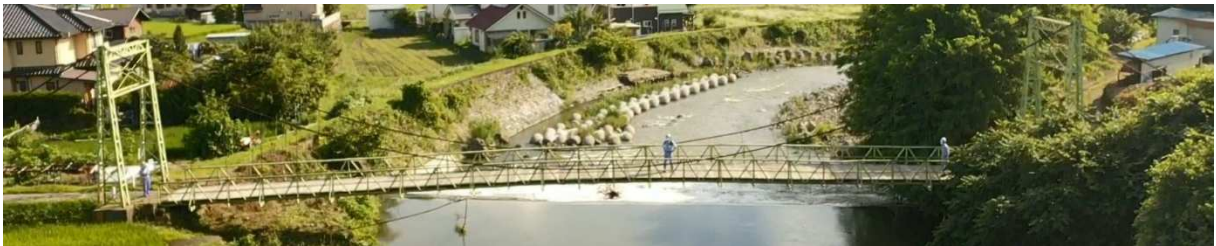
写真1 吊り橋の全景
