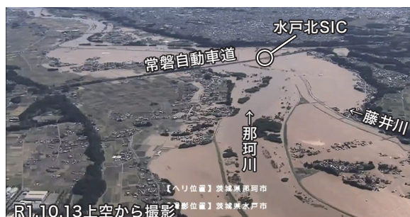
R1.10.13上空から撮影 那珂川の氾濫による浸水状況(茨城県水戸市)
