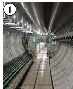
① シールド坑内施工状況 (R2.6時点)
