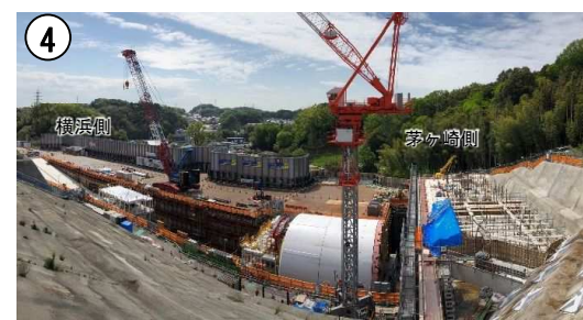
④ 横浜坑口施工状況 (R3.4時点)
