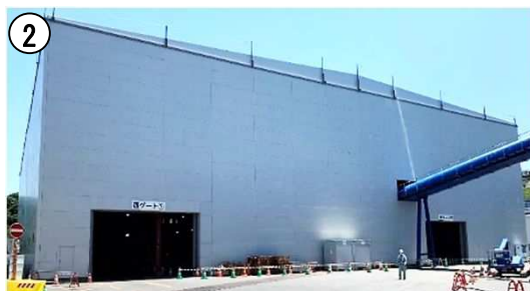
② 発進立坑地上設備 (R1.6時点)
