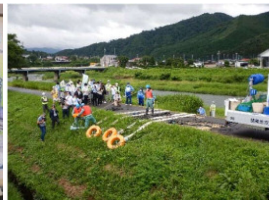
排水ポンプの設置の様子
