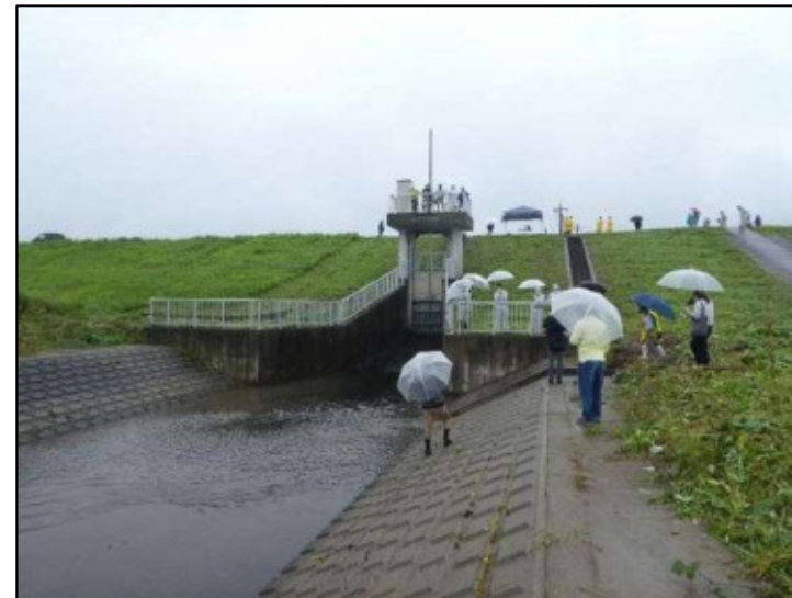
城東地区樋門操作訓練
