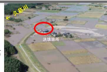
久慈川における浸水被害状況
