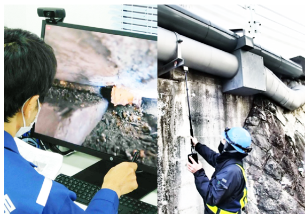
写真-3 遠隔現地確認の試行(左:関東 MC, 右:現地)
