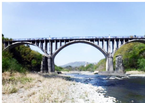
写真-2 秩父橋(埼玉県秩父市)
