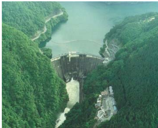
二瀬ダム (F,N,P) : 国 治水容量 2,180万m 3 完成年 昭和36年
