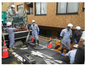
・小型の車両、重機を選定し、作業帯を小規模化することで、通行止め等を回避した。
