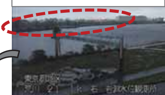
高水敷浸水前
