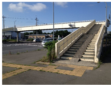
〈酒門第一歩道橋〉 (国道6号 水戸市酒門町)
