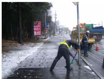
〈歩道除雪作業状況〉
