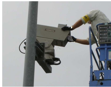
〈CCTV設備 定期点検状況〉
