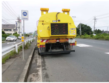
〈路面清掃状況（機械）〉
