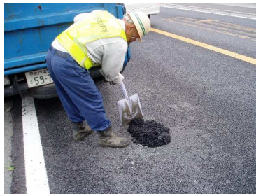
〈ポットホール補修状況〉
