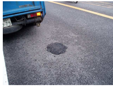
〈ポットホール補修後〉
