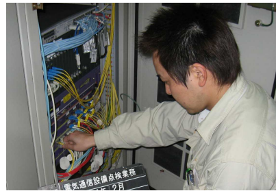
〈通信設備 定期点検状況〉
