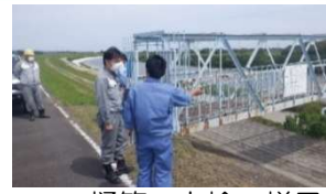
樋管の点検の様子
