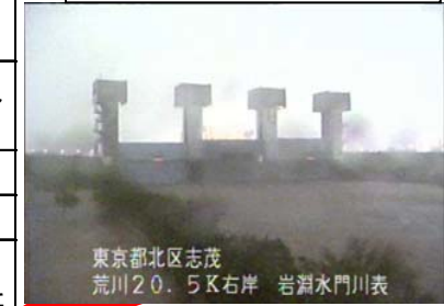
岩淵水門閉操作の状況
