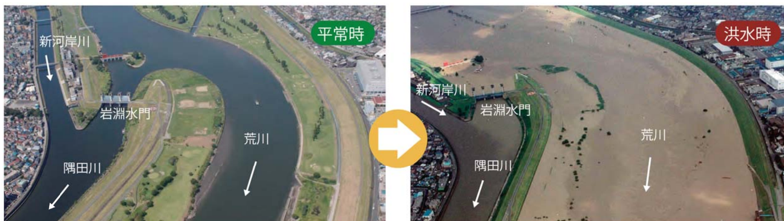
岩淵水門周辺における平常時と洪水時(平成11年8月)の比較
