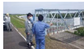
樋管の点検の様子
