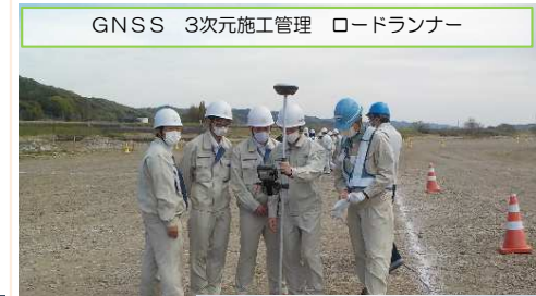
GNSS 3次元施工管理 ロードランナー
