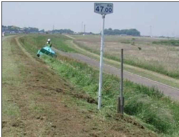
堤防草刈状況
