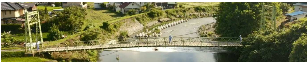
写真1 吊り橋の全景
