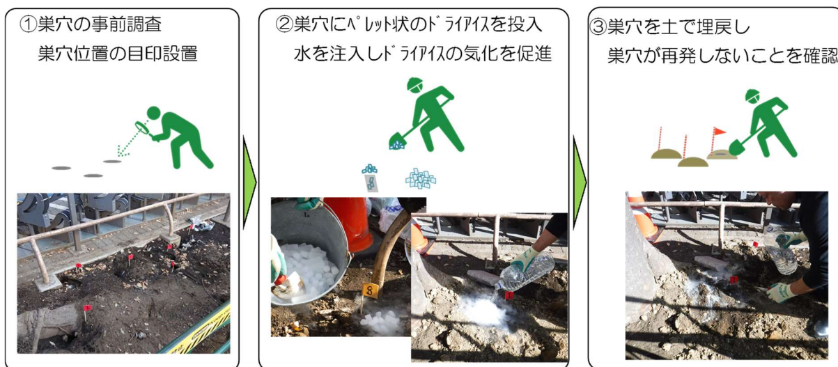
図-2 ドライアイスを用いたネズミ駆除の実施手順
