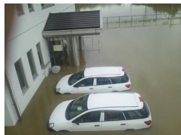
(写真3) 玄関付近
