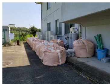
(写真8) 大型土嚢囲み
