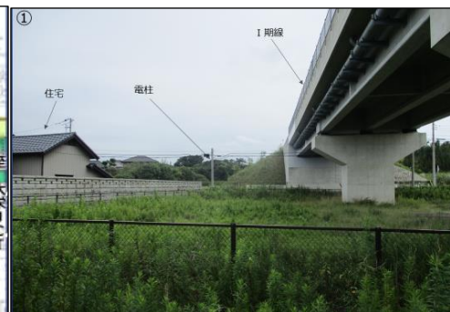
図-3 高第一橋付近の現況写真
