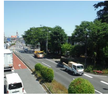
写真1 代執行前の国道側の状況
