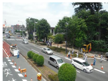
写真3 代執行中の国道側の状況
