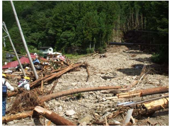
図 1 H 2 7 . 9 被害状況
