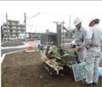
写真 スクリューウエイト貫入試験
