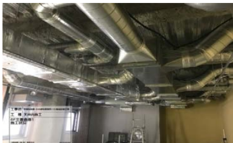
図6 工場加工ダクト(2) : 現場
