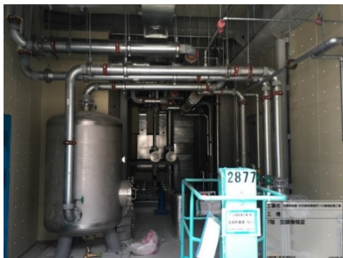
図8 工場加工管(2) : 現場
