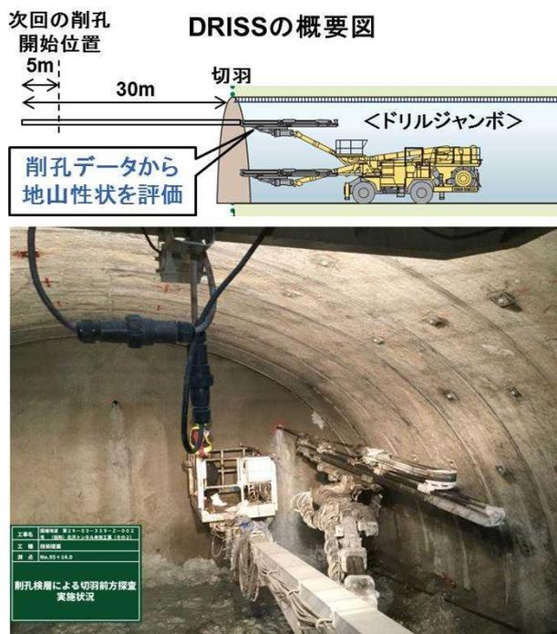
図-5 ドリルジャンボによる切羽前方探査の概要図と実施状況写真
