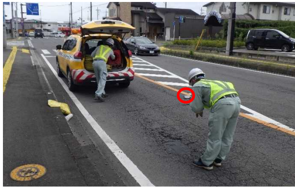
写真-2 パトロール班の作業状況(ポットホール)
