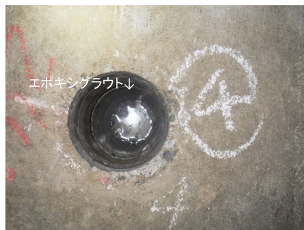
写真-3 充填確認孔No.4 充填状況
