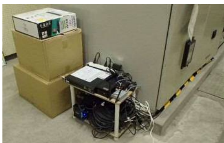
写真-1 計測装置設置状況
