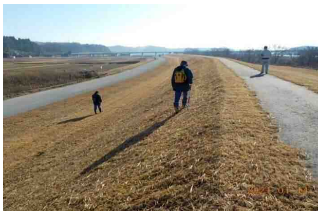
写真-3 堤防点検の様子(冬場)
