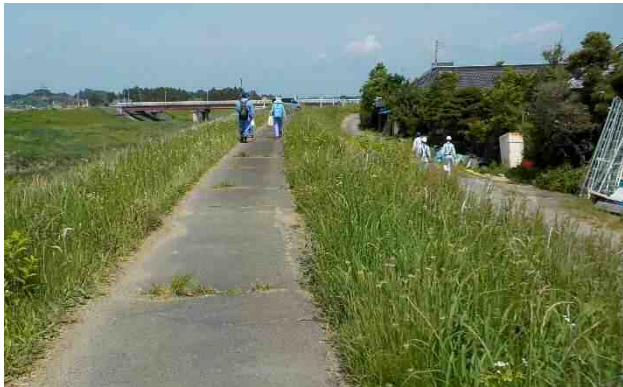
写真-1 堤防点検の様子(6月)
