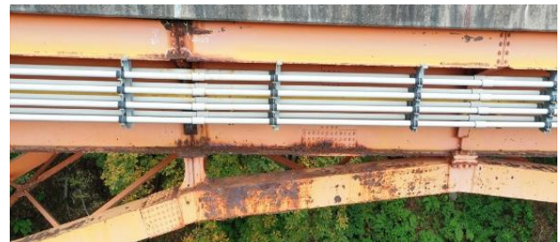
写真-5 法師大橋におけるドローンの撮影写真
