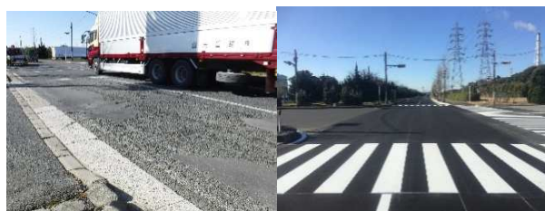
図-6 舗装修繕工事未実施箇所および舗装修繕工事竣工箇所
