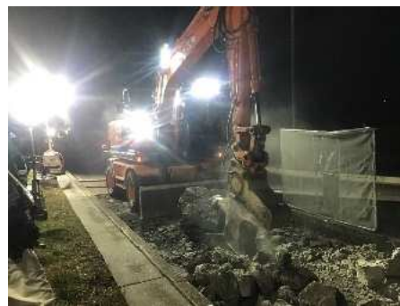
図-3 既設コンクリート版撤去施工状況
