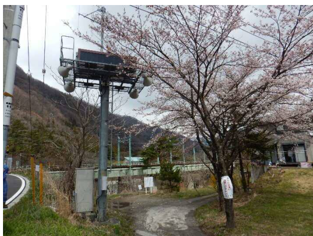
写真-6 支障木のある放流警報局の例
