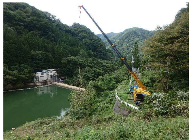
写真－2 支障木の伐採状況
