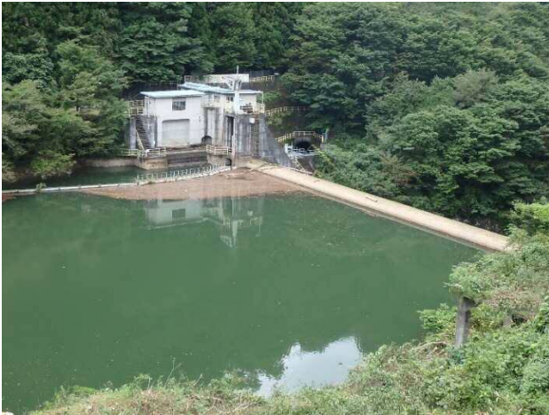
写真-3 支障木伐採後の小森ダム
