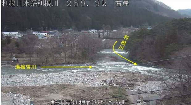
写真-5 伐採後の下流河川の状況 (CCTV画像)
