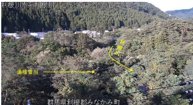
写真-4 伐採前の下流河川の状況 (CCTV画像)
