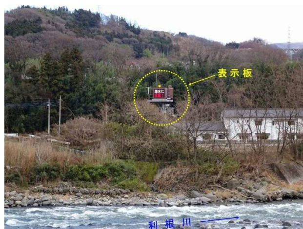
写真-7 表示板の視認性を妨げる支障木
