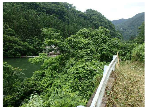
写真－1 支障木伐採前の小森ダム
